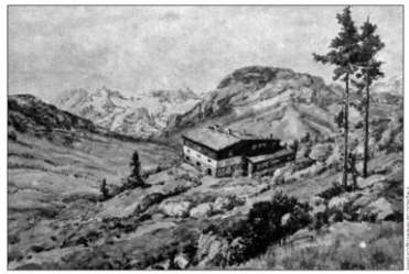
Domžalski dom na razglednici, ki se je prodajala v času gradnje.
